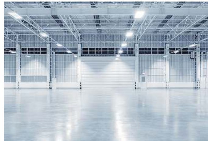
In azienda. Impianto di illuminazione studiato ad hoc per un capannone
